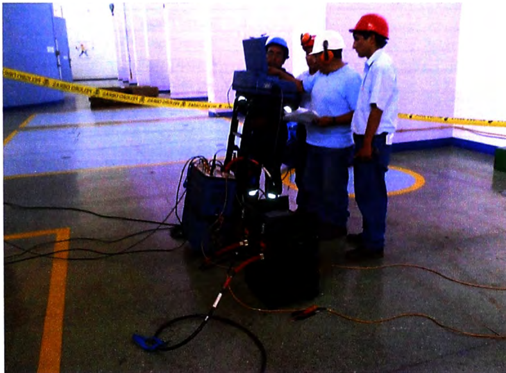
Fig. 3.7 Conexión del equipamiento para la prueba de Tangente Delta
