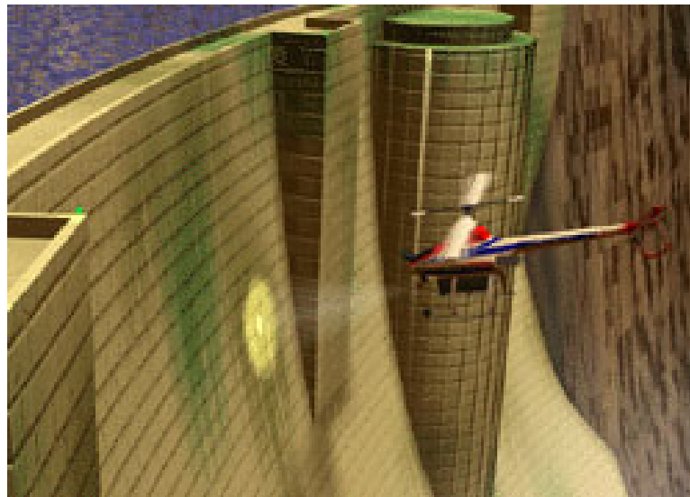
Figura 1.39: Mini helicóptero realizando inspección en una presa.
