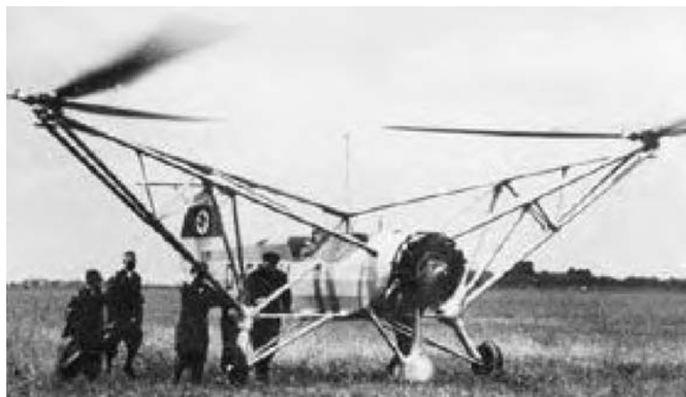
Figura 1.22: El helicóptero Fa-61 (1936) fue una máquina de dos rotores de lado a lado. Este es el primer helicóptero que demostró un completo control de vuelo y exitosas auto-rotaciones.
