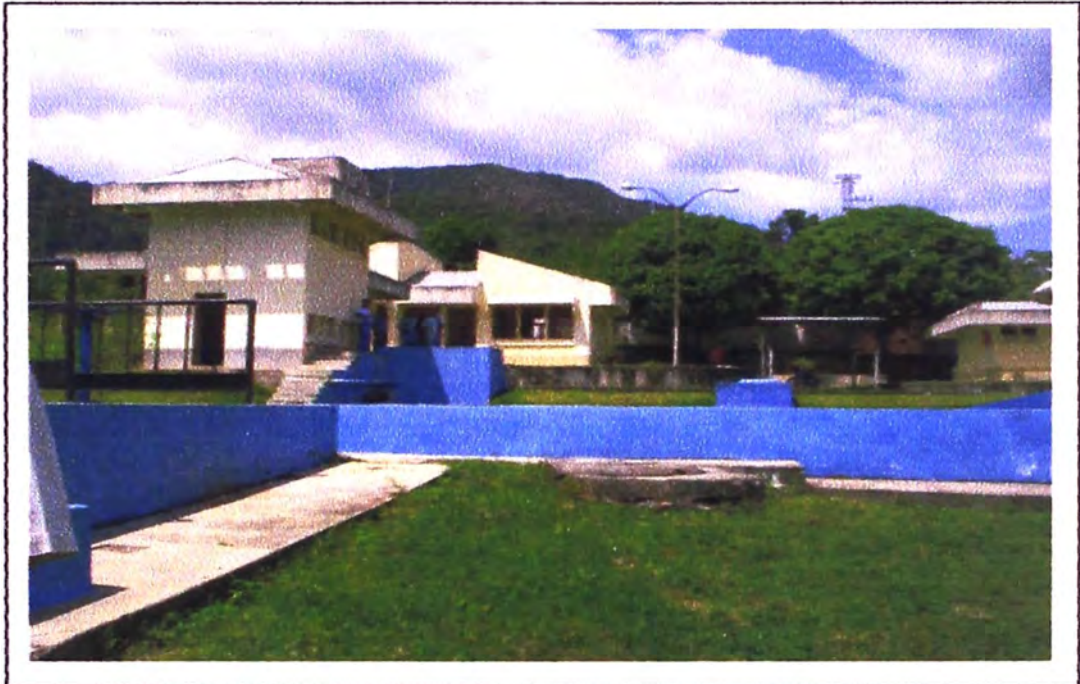
Fotografía N°4: Vista panorámica de la Planta de Tratamiento San Mateo
