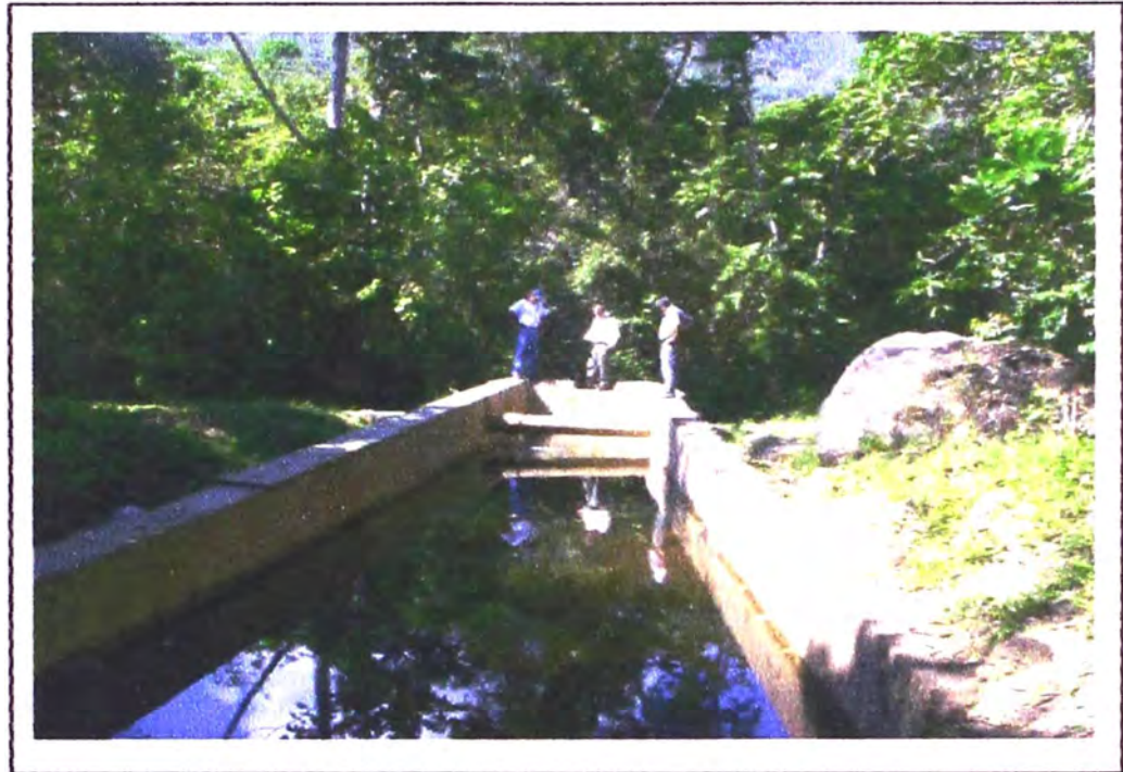
Fotografía N°2: Captación de la Quebrada Mishquiyacu
