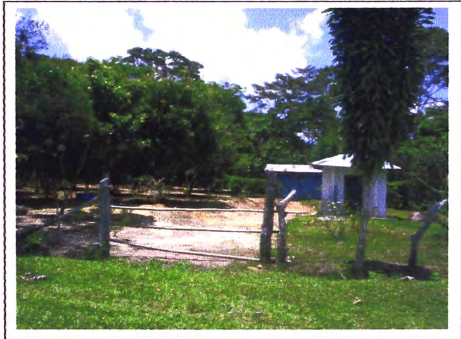
Fotografía N°10: Caseta de cloración de la captación Almendra
