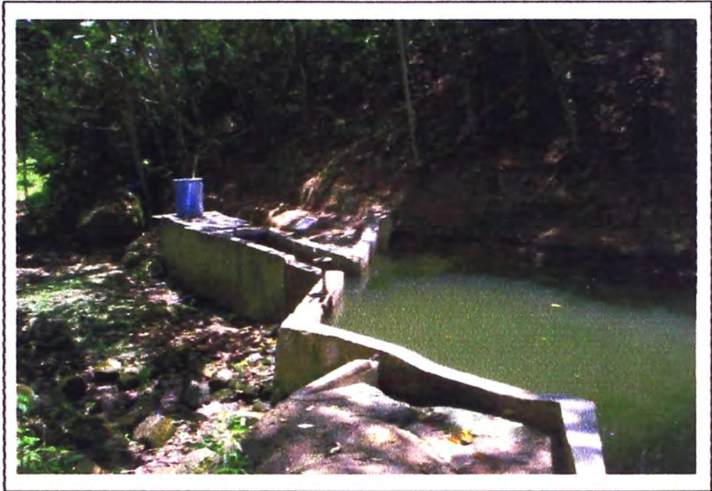
Fotografía N°3: Captación de la Quebrada Almendra
