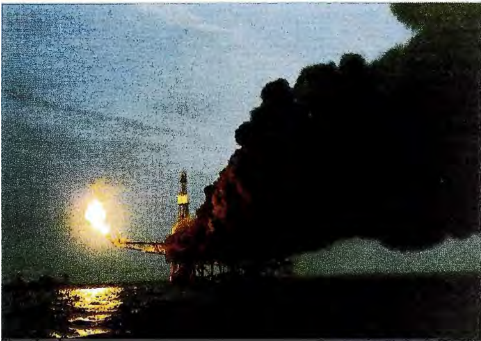
Figura 1.8. El incendio producido luego de la primera explosión. Nótese el humo cubriendo totalmente las viviendas y el helipuerto.
