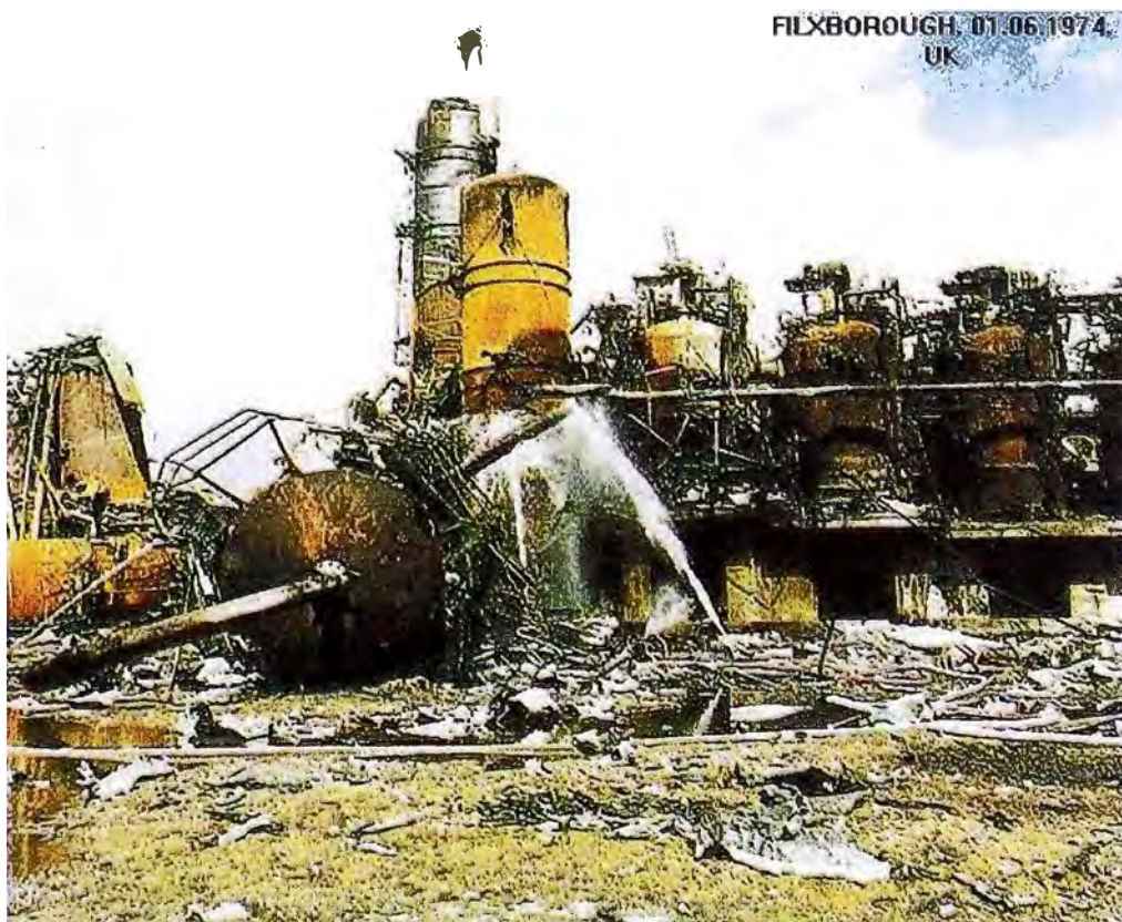
Figura 1.3. Restos de la Sección de reactores de ciclohexano.
