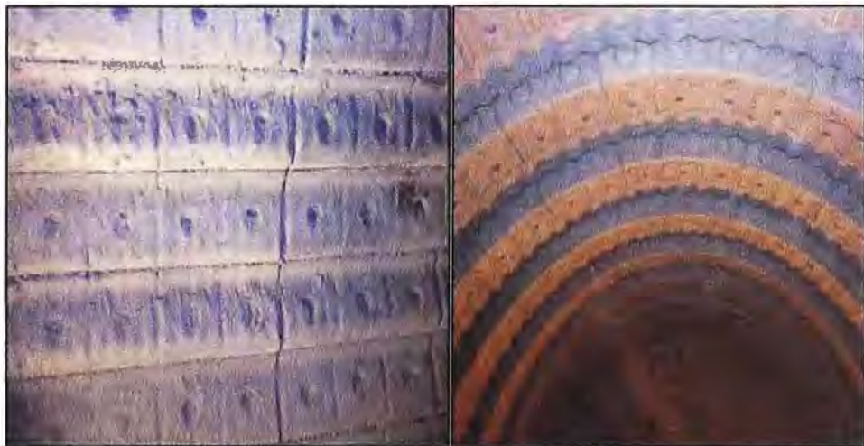
Figura 5.6. Blindajes en el interior del molino
