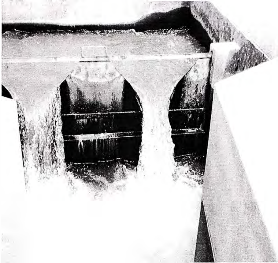
Se muestran los vertederos del Canal Parshall. La Planta de Bellavista trata 120 l/s.
