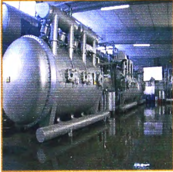
VISTA LATERAL DE LA PLANTA DE TINTORERIA
