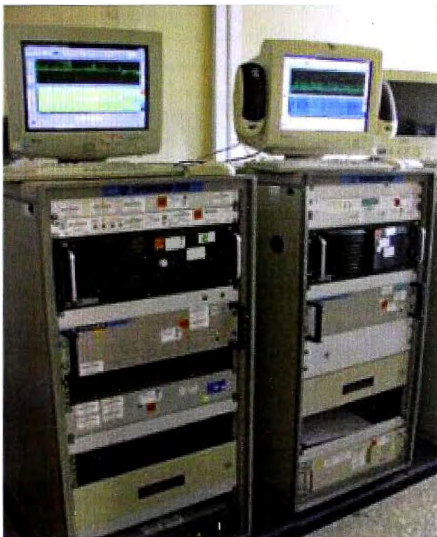
Figura1.5 Estación fija de comprobación técnica y radiogoniometría Fotografía Estación fija THALES (sede central MTC, 2012)
