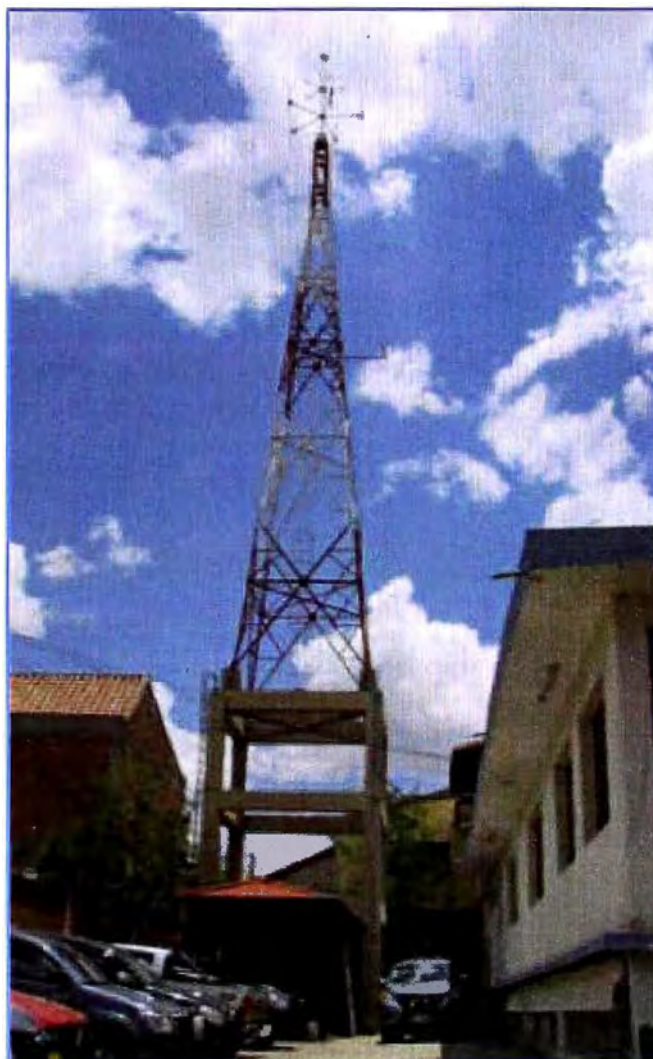
Figura1.3 Estación fija de comprobación técnica Fotografía Estación fija THALES (sede Cusco MTC, 2013)
