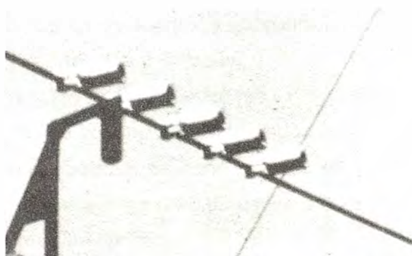
Fig. 2.29 Instalación de cinco dispositivos AR Twister sobre el conductor [12].
