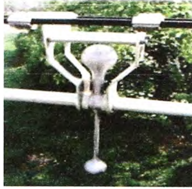
Fig. 2.42 Amortiguador torsional y desafinado (TDD) [8].
