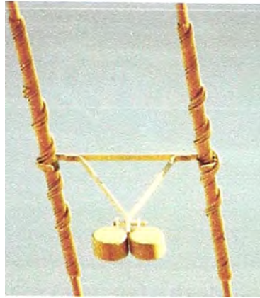
Fig. 2.40 Péndulo de desintonización instalado en un conductor de haz doble en Nebraska (Pon y Havard, 1994) [12].
