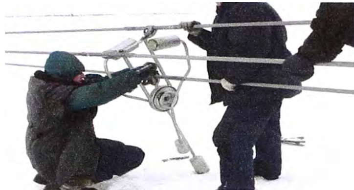
Fig. 2.43 Amortiguador torsional y desafinado (TDD) instalado en una haz de línea triple [8].
