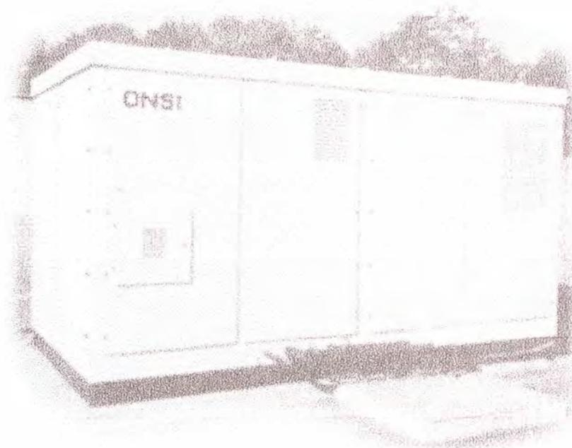
Fig. 2.18 Celda de combustible PC-25
