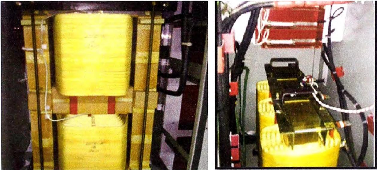
Fig.4.11. A la derecha se muestra una reactancia DC conocida como DC-link, a la izquierda muestra una reactancia en AC utilizado en Drives del tipo PWM [9].
