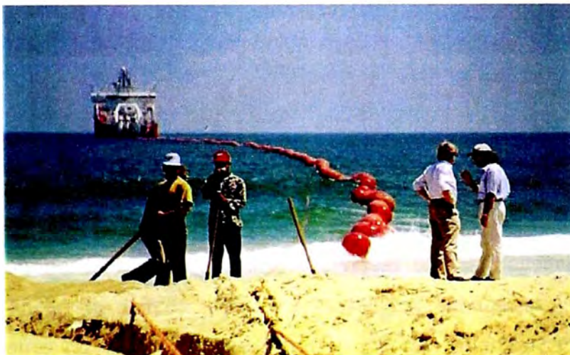
Figura 2.9 Amarre de un cable submarino
