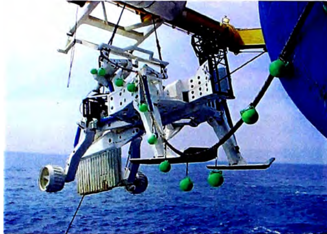
Figura 2.10 Arado submarino para la instalación de zanjas
