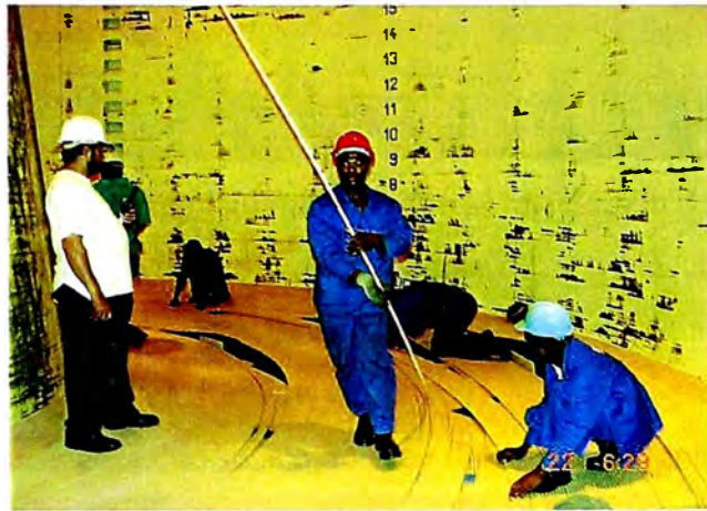
Figura 2.8 Preparación del cable en la bodega
