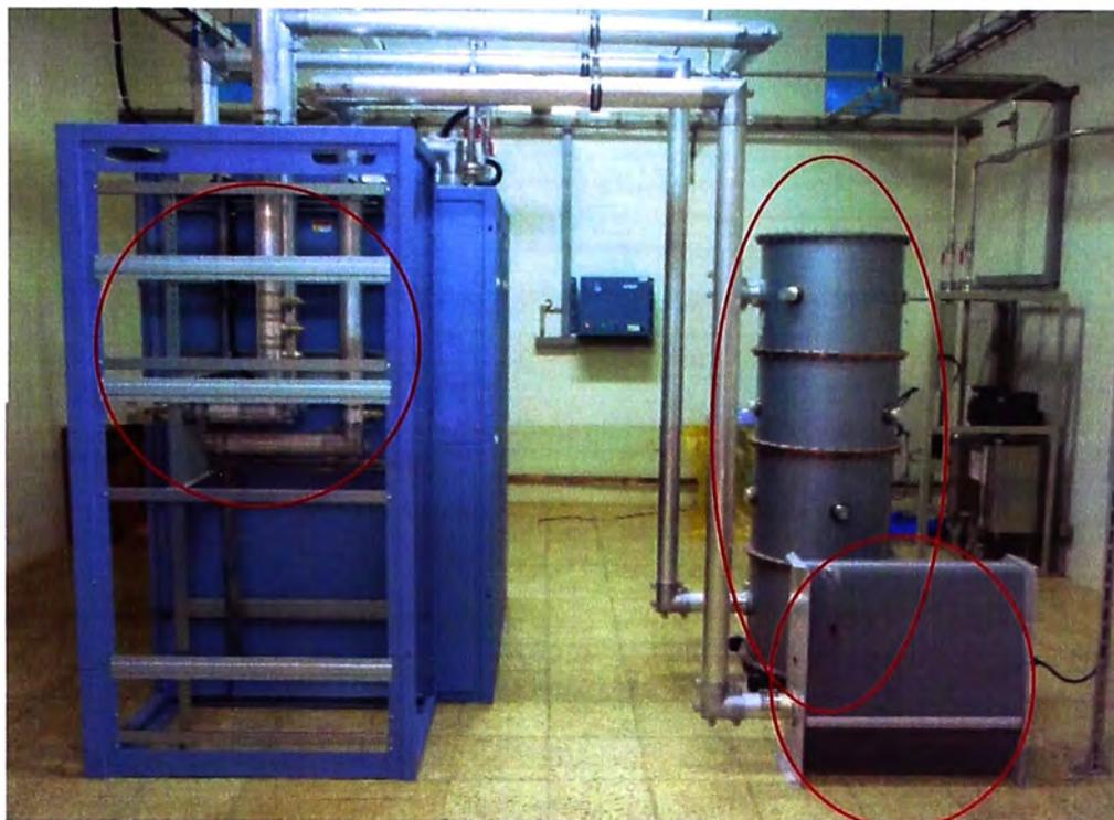
**Fig.3.13** Ambiente del transmisor, filtro pasa banda, conmutador coaxial y carga fantasma (Fuente: IRTP)
