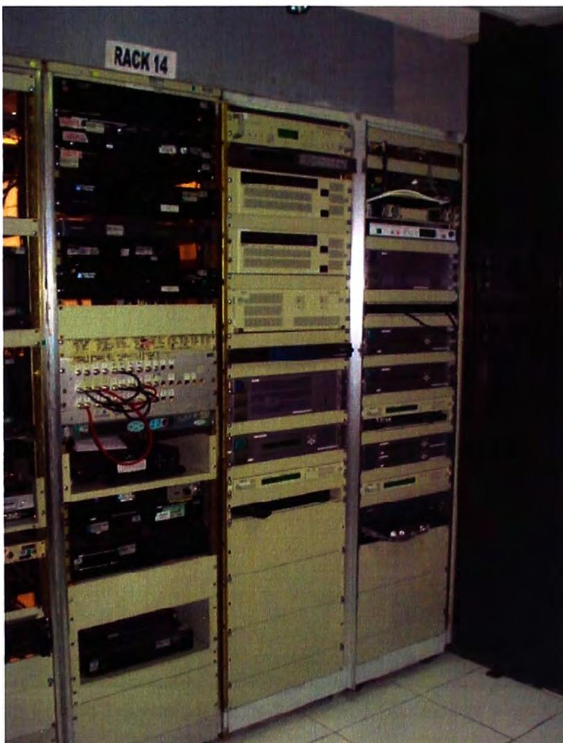
**Fig.3.11** Equipos codificadores y multiplexor, instalaciones de IRTP (Fuente: IRTP)
