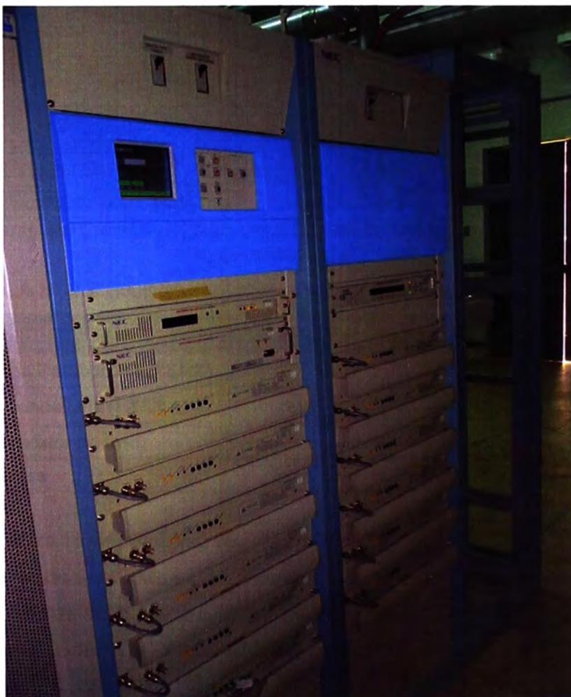
**Fig.3.12** Equipo Transmisor ISDB-T en Cerro Marcavilca (Fuente: IRTP)
