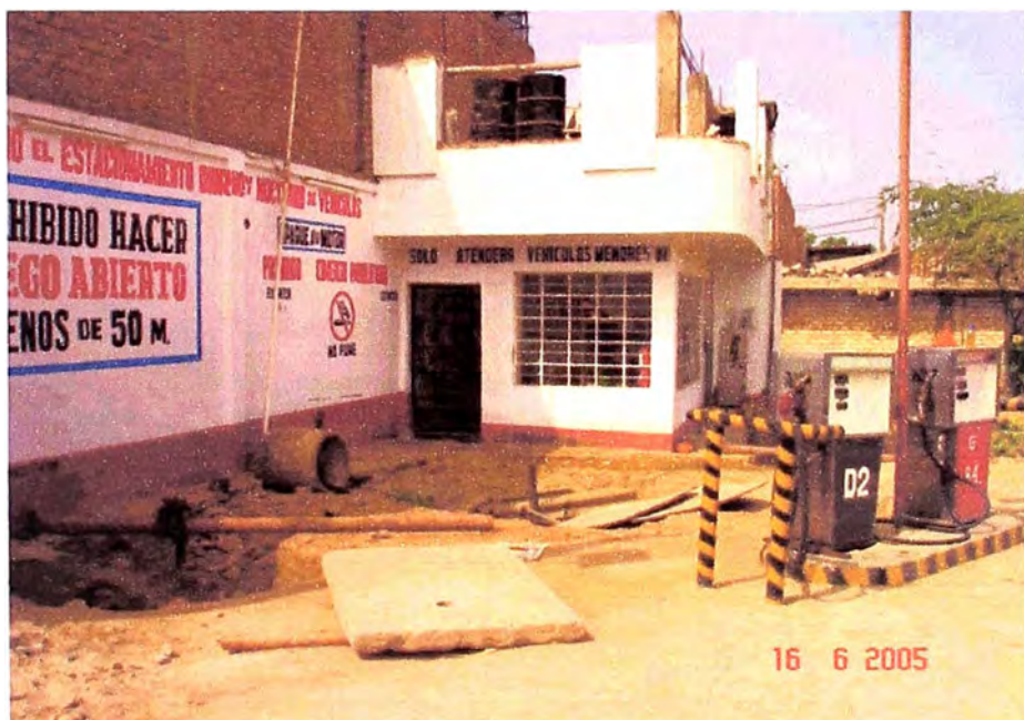
Foto N° 1. Vista Panorámica de las instalaciones donde se observa las excavaciones de tierra.
