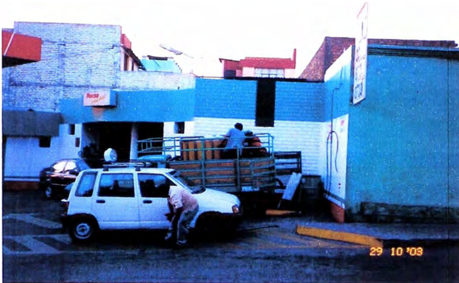
Foto N° 1. Vista de llenado al tanque de combustible con un isotanque de 250 galones, practica frecuente en muchos establecimientos, era necesario intervenir el establecimiento.
