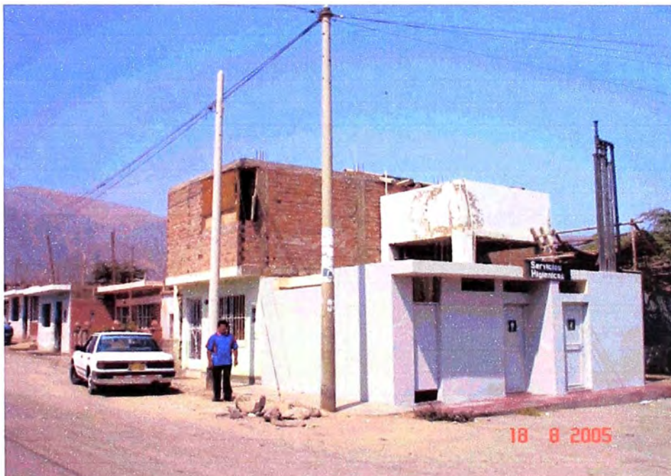
Foto N° 2.- Vista del Sistema de recuperación de vapores y usuario que presento la denuncia ambiental.
