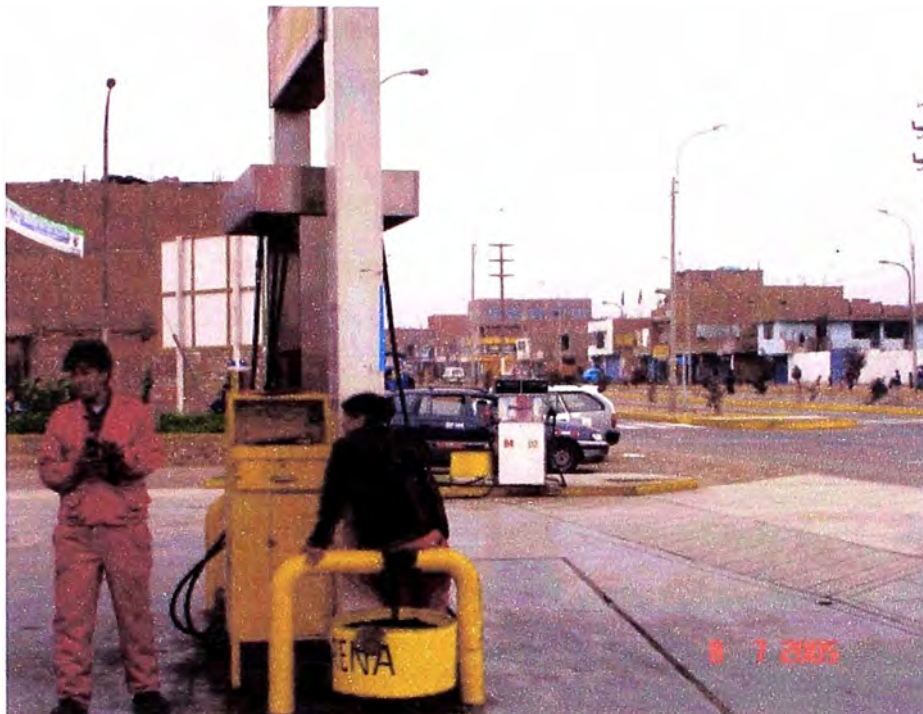
Foto N° 3. Vista del surtidor ubicado en posición insegura, obsérvese la cercanía de los carros.
