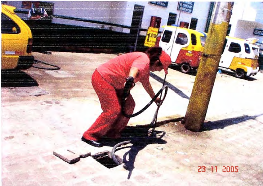
Foto N° 3. Sacando la manguera de Diesel 2 enterrada
