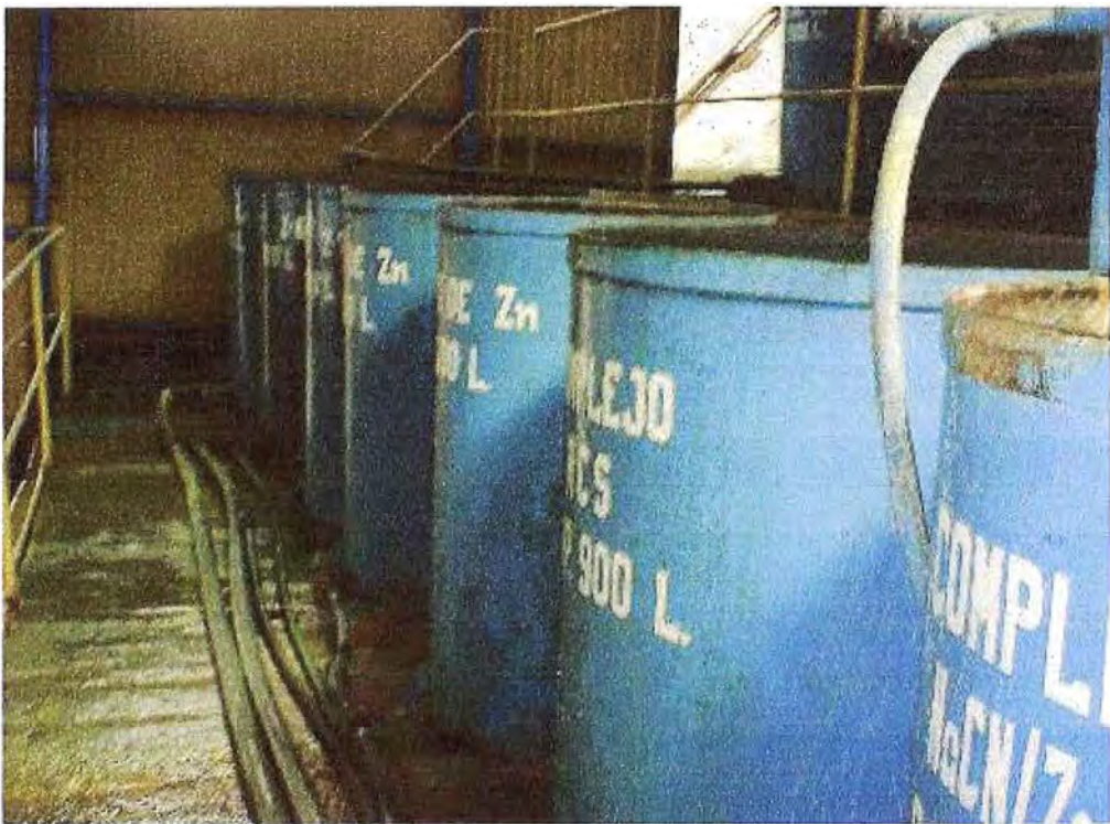
Figura 2.3 Tanques de preparación de reactivos para flotación
