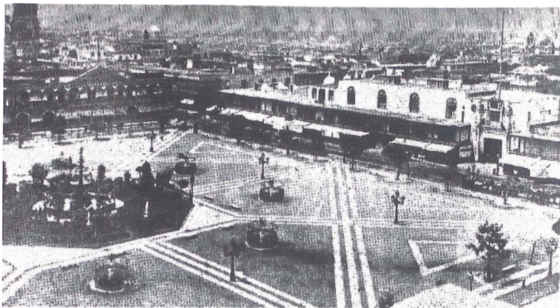
Foto Tomada en 1872, desde una torre de la Catedral. Como se observa, se ha añadido un tercer nivel, pero el esquema es el mismo, al que se trazó en los días de la fundación de la ciudad.
