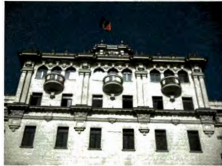
Gráfico N°102: Cuerpo central trabajada a modo de tribuna. con la presencia de pilastras adosadas.
