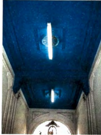
Gráfico N°114: Detalle de trabajo en cielo raso.
