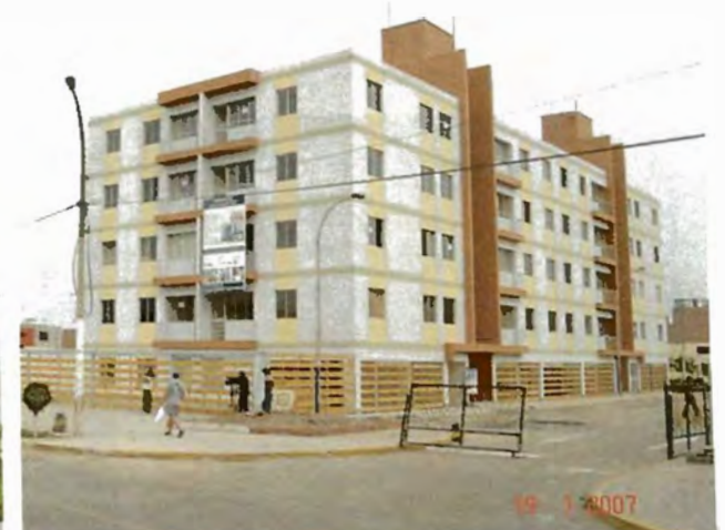
FOTO: DESDE CALLE CONTRALMIRANTE LIZARDO MONTERO
