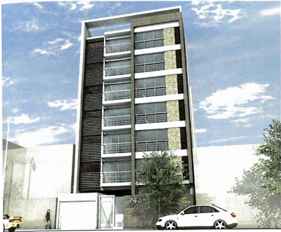
VISTA DE FACHADA PRINCIPAL
