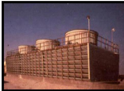
**Figura 4.17 TORRE DE ENFRIAMIENTO TIPO HÚMEDO**
