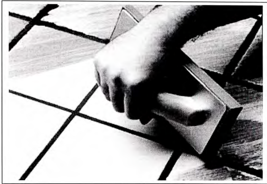
Figura 14. Aplicación de un mortero para juntas.
