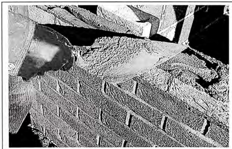
Figura 11. Mortero para asentamiento de ladrillos.
