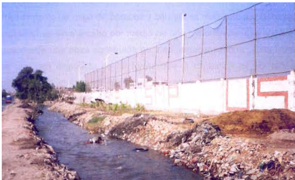
Vista General de un tramo del Canal Surco en el distrito de Santa Anita
