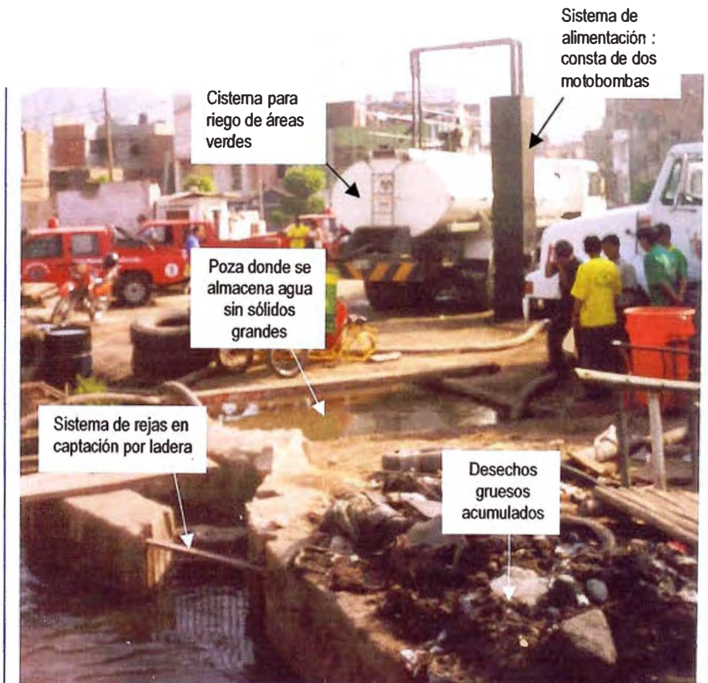
Sistema de Captación para riego realizado actualmente en el distrito de Santa Anita
