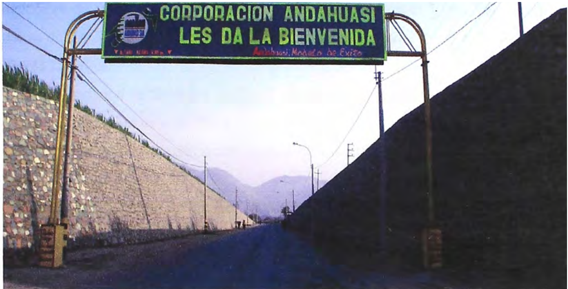
Figura N°1 : Altura del kilómetro 40,5 de la carretera Huaura-Sayán Provincia de Huaura
