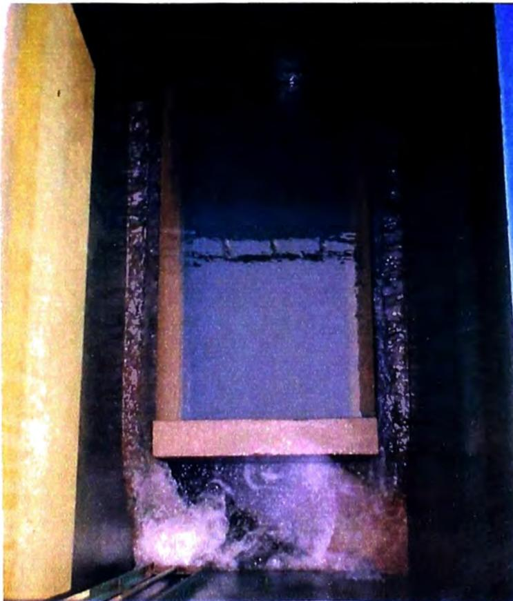
**FOTO 9A.- FILTRO RECIEN LAVADO: SE OBSERVA EL INGRESO DE AGUA DECANTADA (COMPUERTA DE ENTRADA).**
