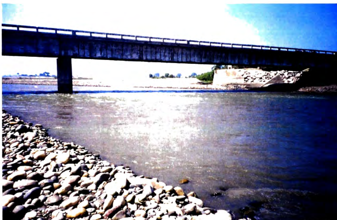
Figura N°3.15: Puente Santa en la desembocadura al Pacífico
