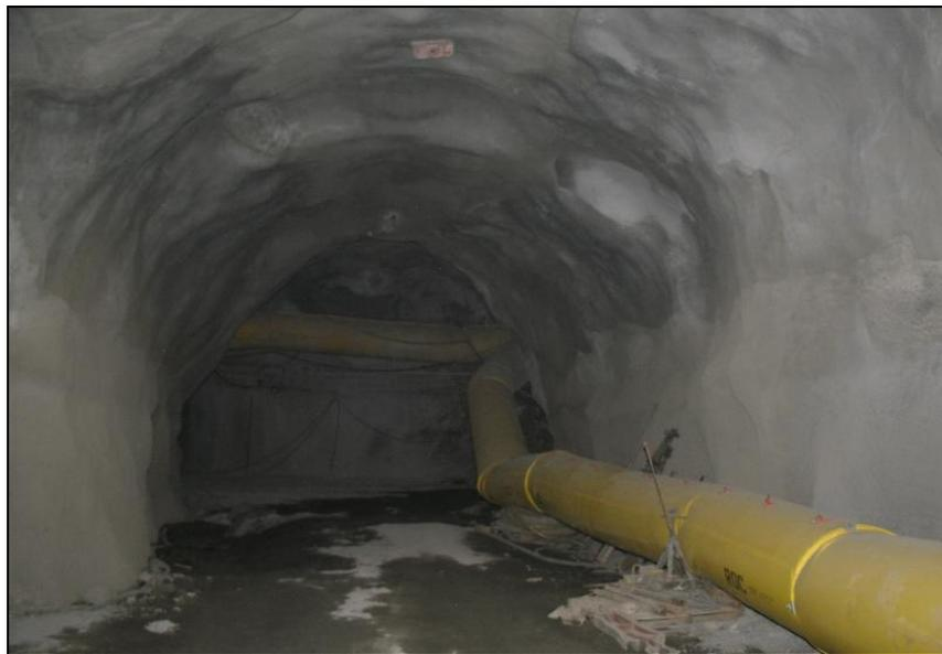
**Fig. 7.1.5.1 Labor con concreto lanzado**
