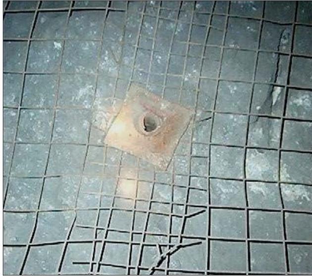
**Fig. 7.1.9.1 Control de Sostenimiento Perno con Malla**
