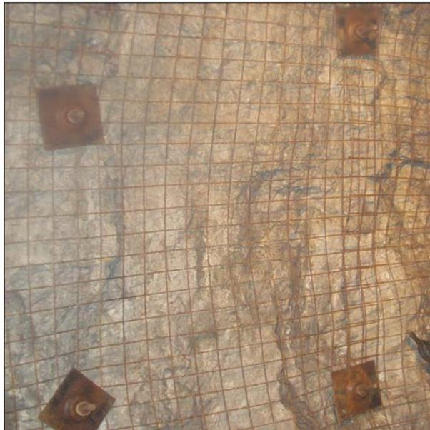
**Fig. 7.1.4.1 Malla Electro soldada con Perno Helicoidal**
