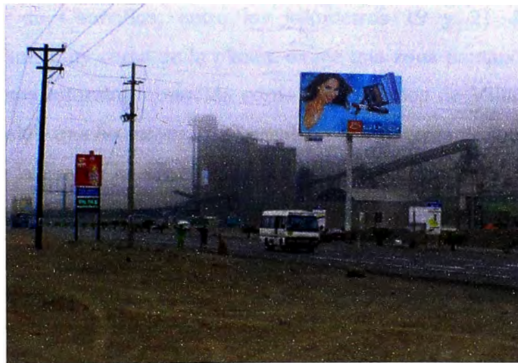
Figura # 09.- Planta y Muelle de Cementos Lima SA.
