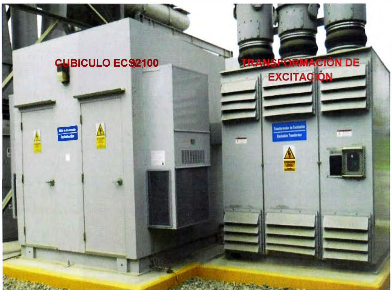
Figura 3.1 Cubículo del sistema de excitación estática TG3 – KALLPA.
