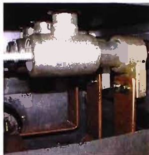
Fig. 4.3 Seccionador fijo de uso interior
