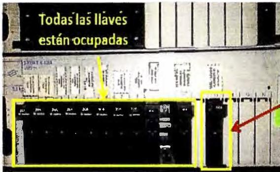
Breaker de 100A (durante el TSS no se pudo fotografiar cuando estaba en OFF. Esta foto se tomó después que se usó para la energización del equipo, razón por la cual está en ON)
