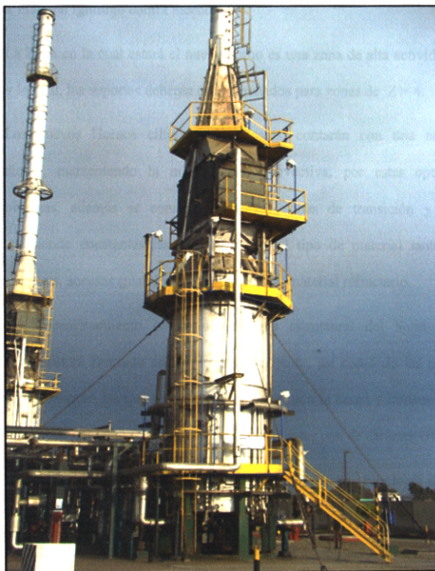
Fig. 1.1 Horno Cilíndrico Vertical autosoportado a ser reemplazado de 8MBPD Refinería Conchán - Lima
