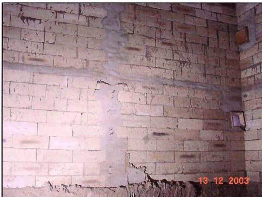
**Foto N° 18: Pared de ladrillos machimbrados con columna al centro**
