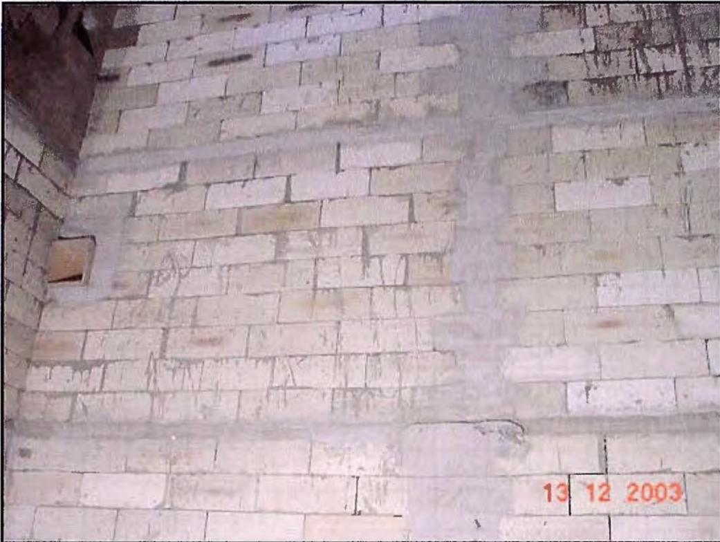
**Foto N° 19: Ladrillos machimbrados con columna al centro**
