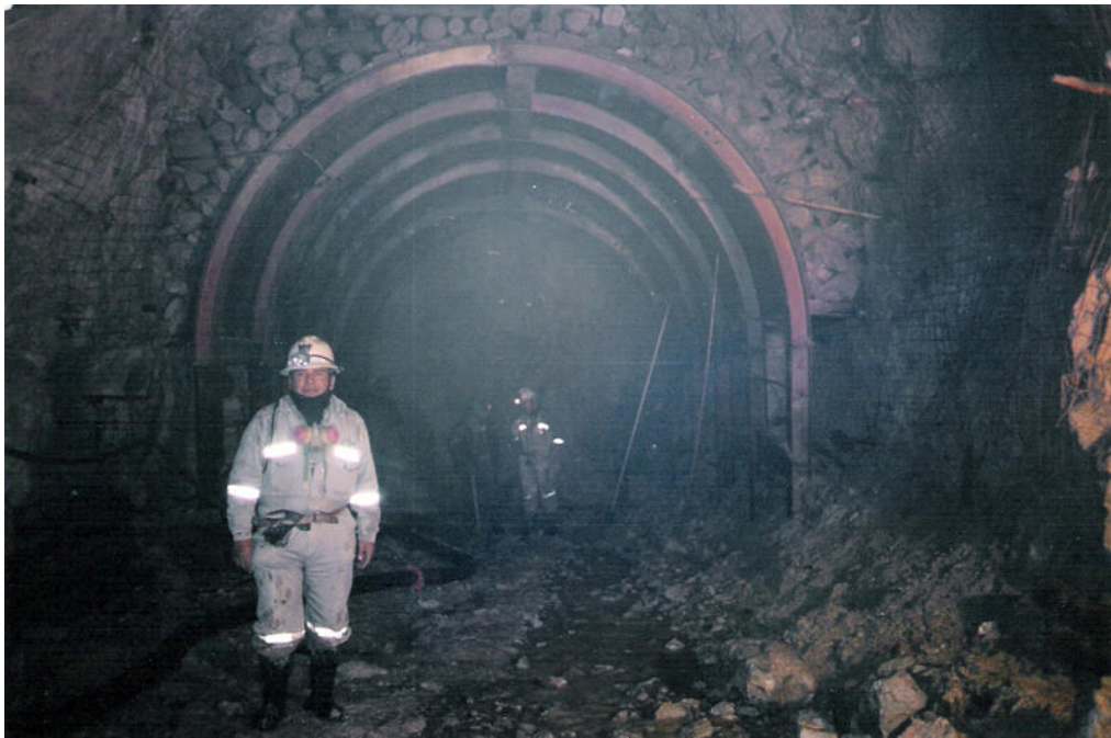
Foto N° 4: Dentro de interior mina
