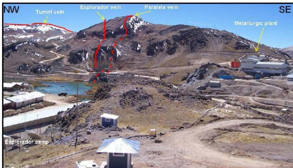
Figura 1.2: Vista panorámica de la mina
