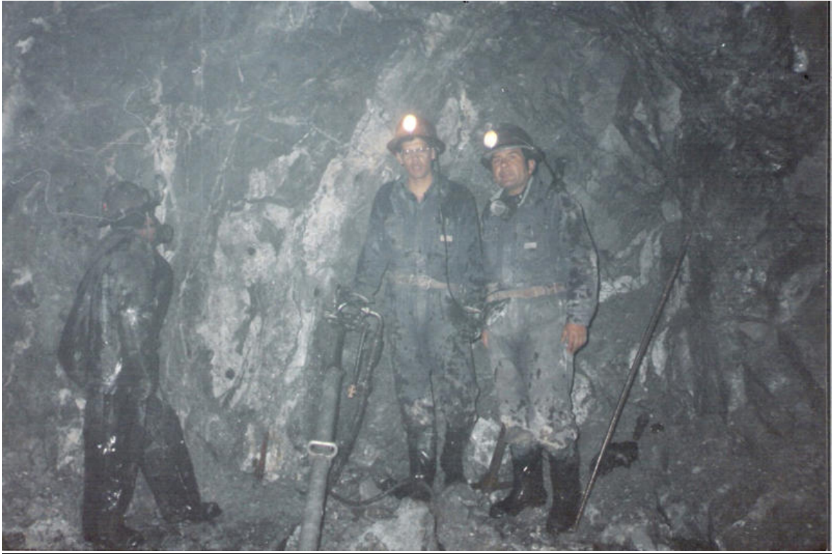
Foto N° 5: Inspeccionando el avance
