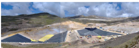
Poza de Operaciones y Tormentas (Vista de Norte a Sur)
