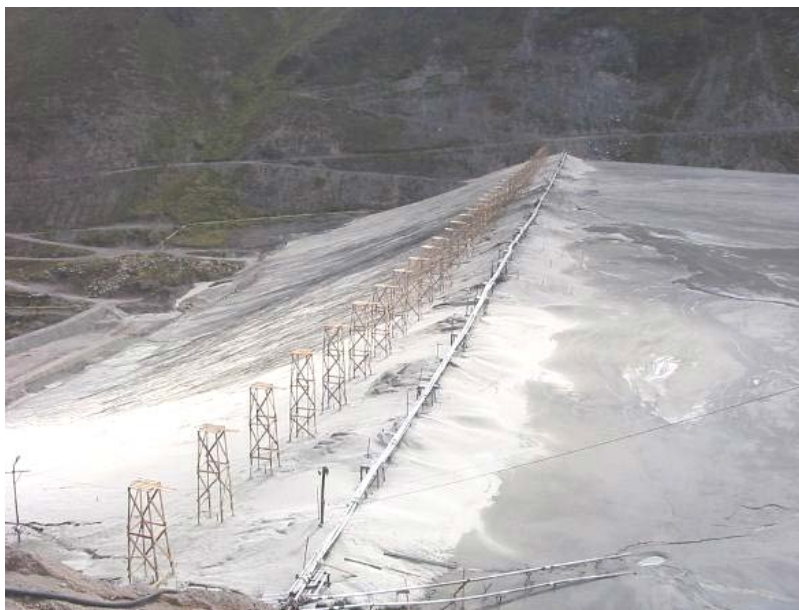
Figura 13: Vista Panorámica de la relavera Chinchán.
