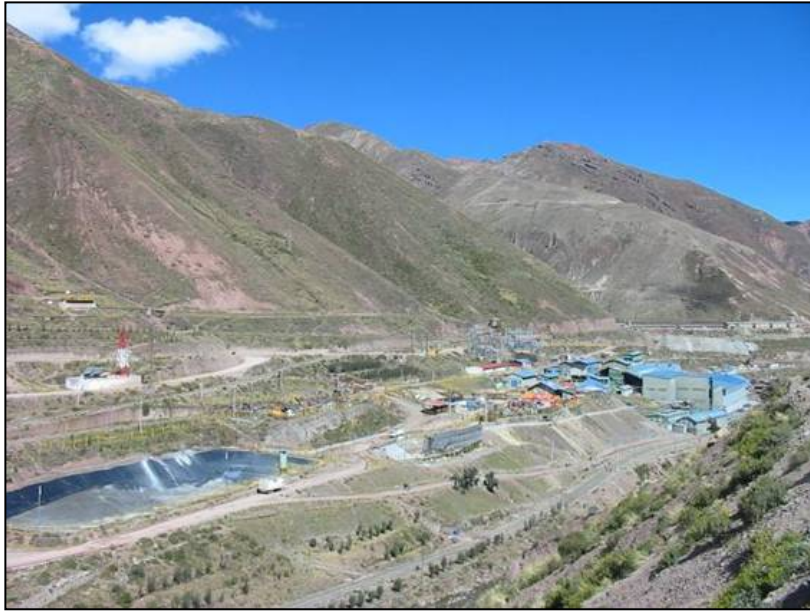
Figura 14: Vista Panorámica de las instalaciones de bombeo
