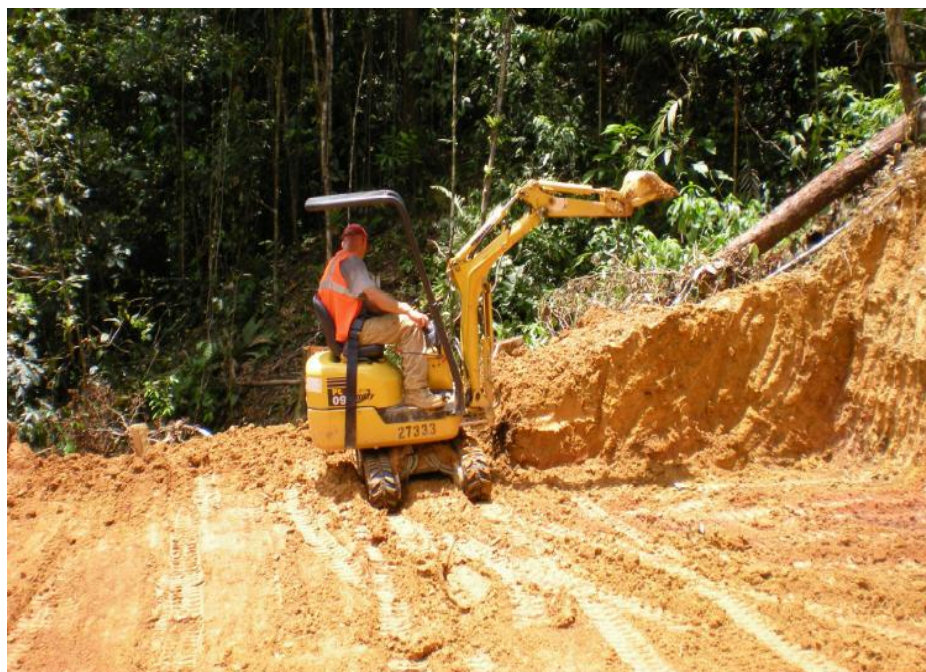
Foto 12: Plataforma de perforación diamantina; pozo B07035
