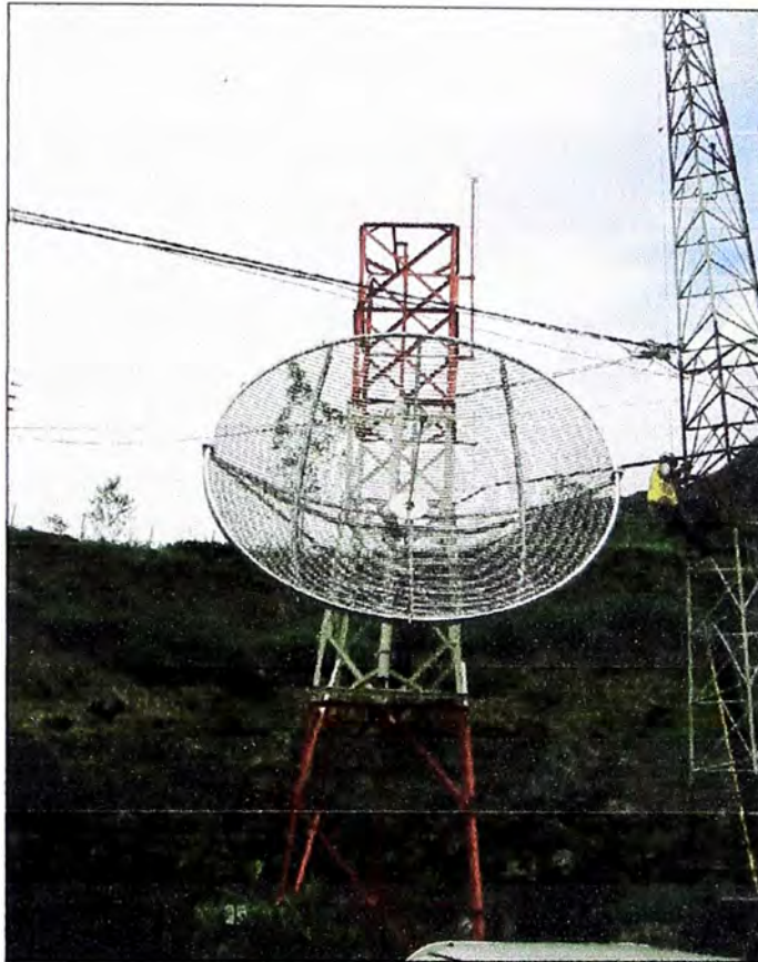
FIGURA 4.6 Vista fotográfica de la Torre C.H. Yanango
