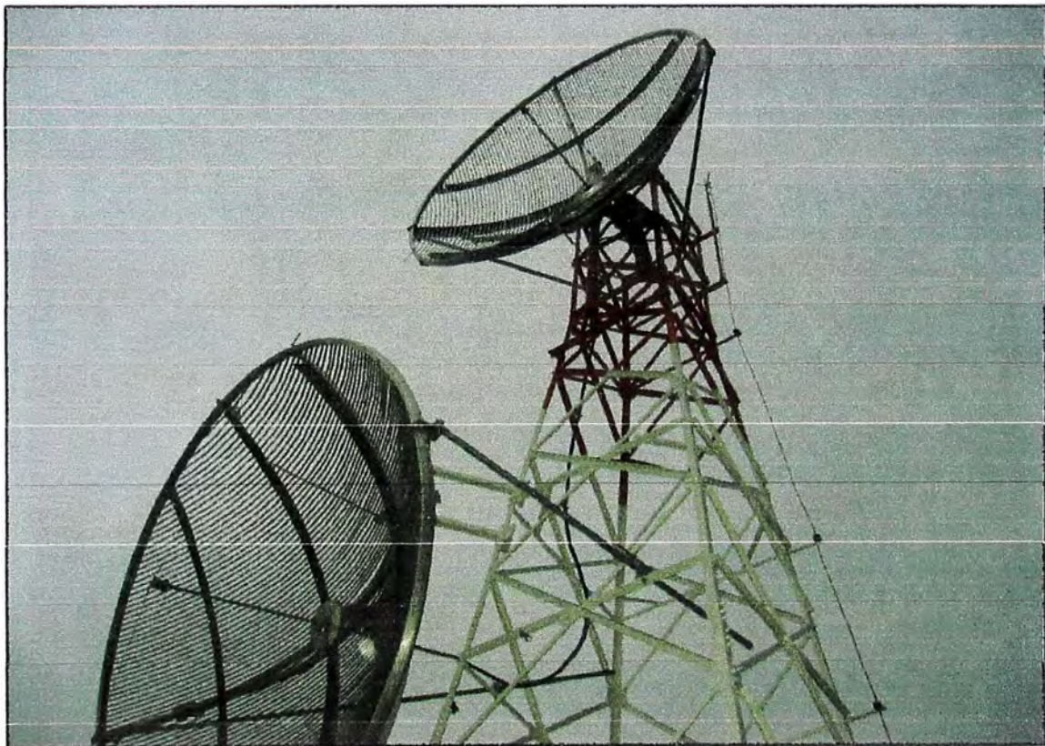
FIGURA 4.5 Vista fotográfica de la Torre Cerro Primavera.
