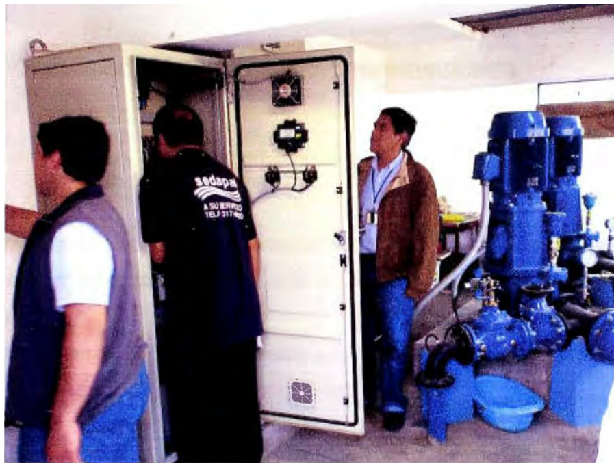
FIGURA 5.1 Supervisión en la estación CRE-137A
