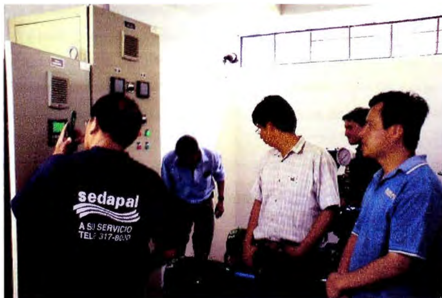
FIGURA 5.2 Supervisión en la estación CP-7G
