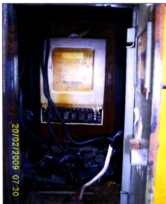
Figura 2.12 Conexión directa provisional
