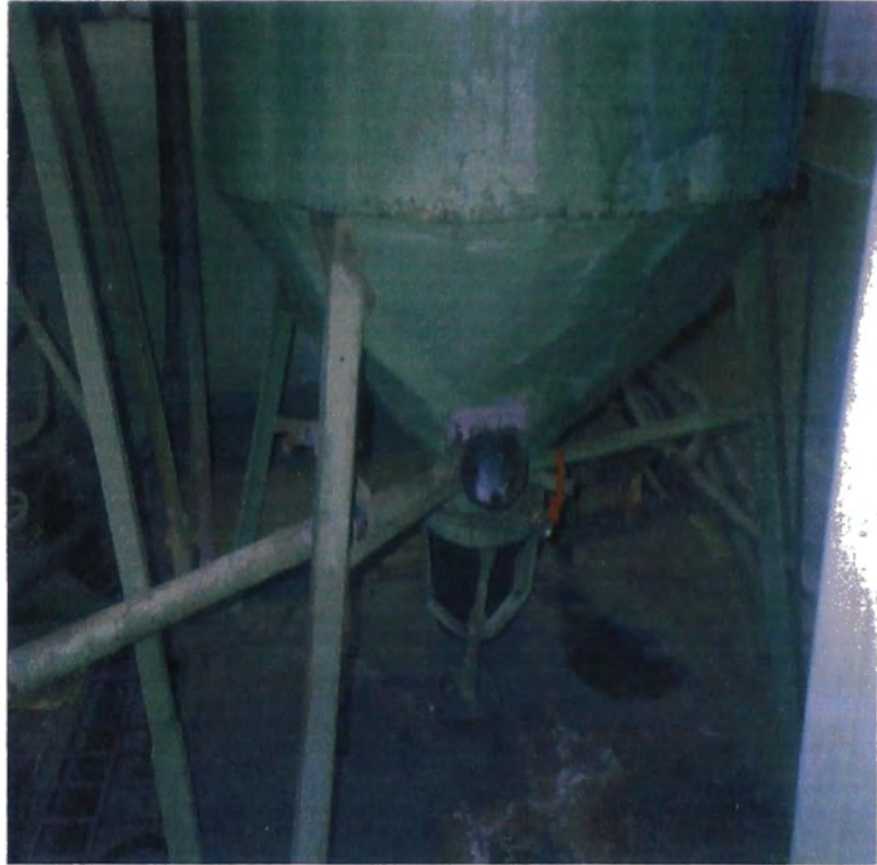
FOTO N° 3 DUCTO DE SALIDA DE CARBON
