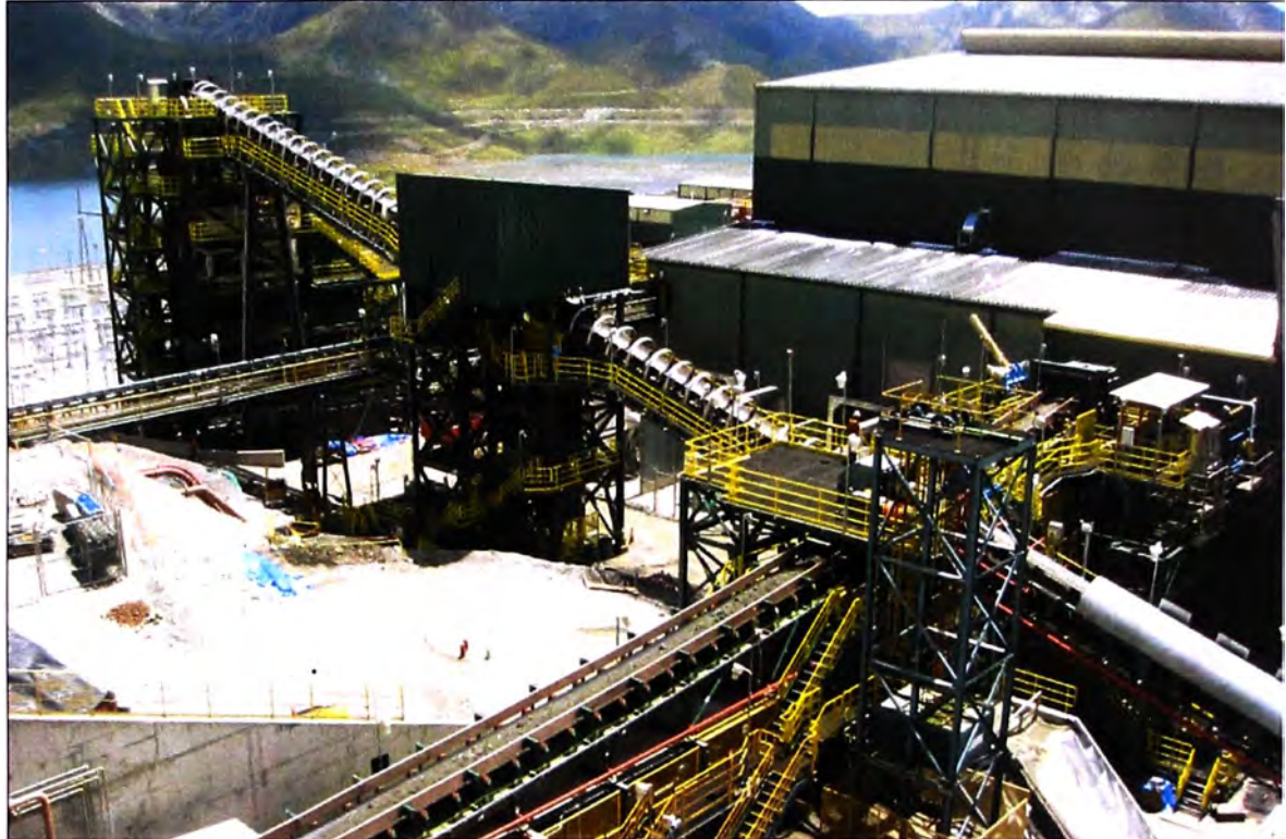
Foto 7 – Tripper, Faja 031, Torre de Zarandas Secas y Pararrayos
