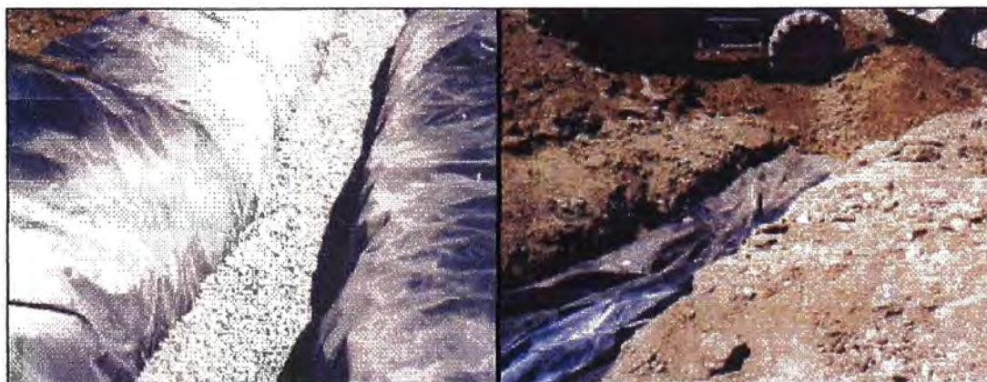
Figura 11. Construcción de un drenaje anóxico calizo.
