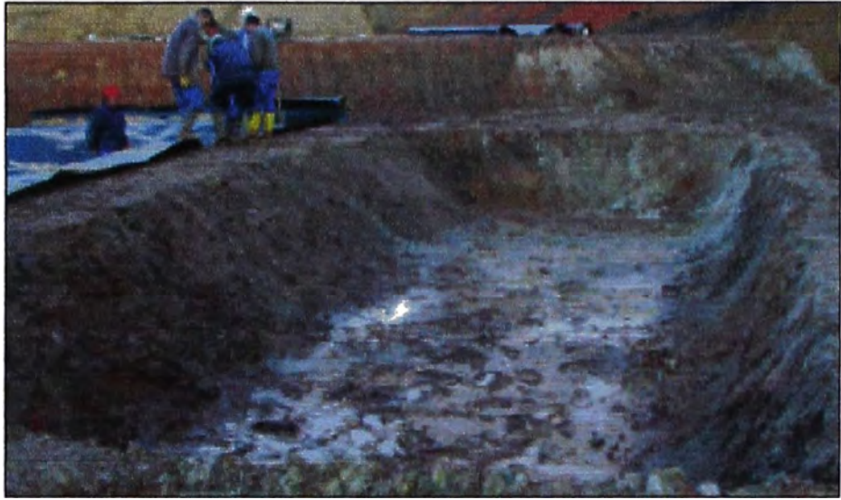
Figura 2. Excavación para la celda de un humedal a escala piloto.
