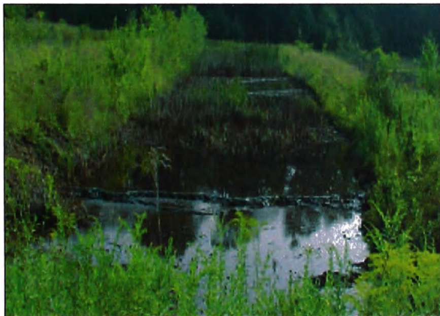
Figura 9. Humedal anaerobio (Maryland, Estados Unidos).
