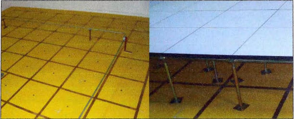
Fig. 2.7 Piso acondicionado con pintura epóxica y cintas de cobre
