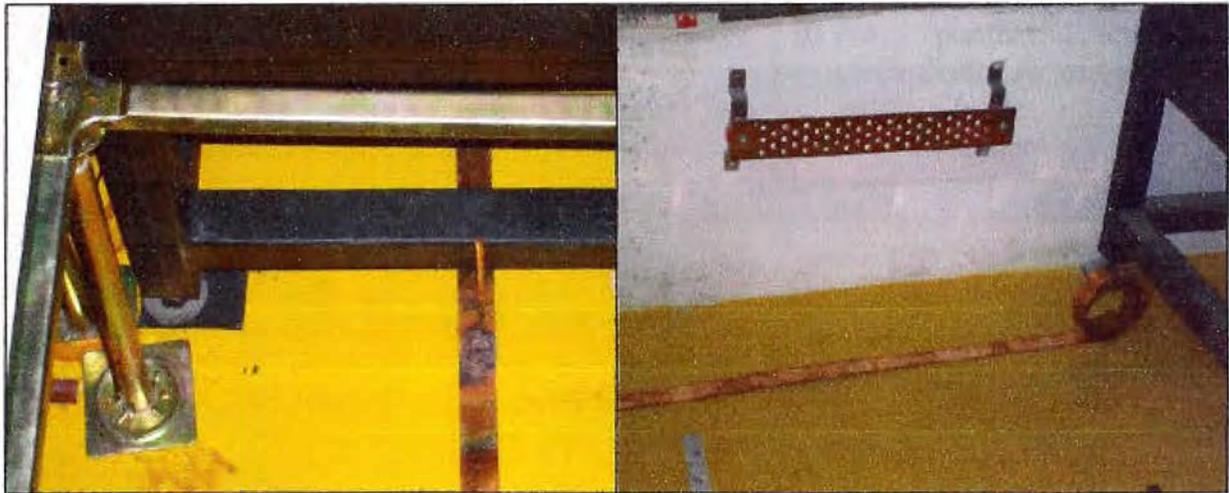
Fig. 2.8 Aterramiento de estructuras e instalación de barraje equipotencial
