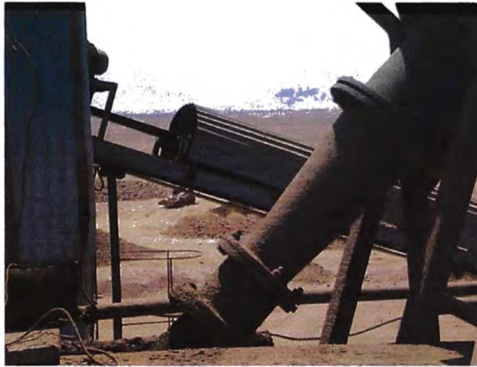
Figura 25: Hidrociclón inclinado usado en la Planta.
