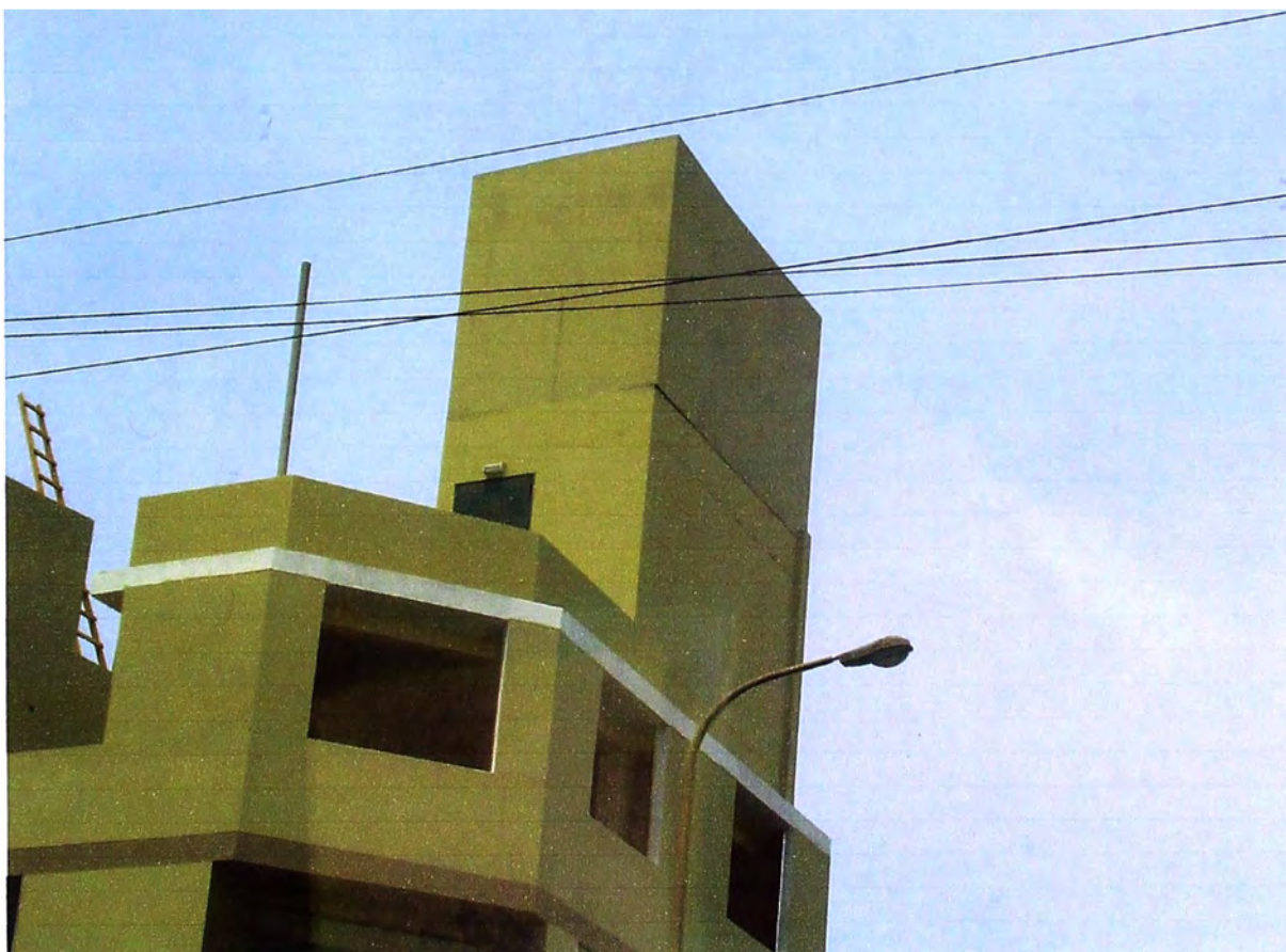
FIGURA 4.1 Estación Base Celular Mimetizado
