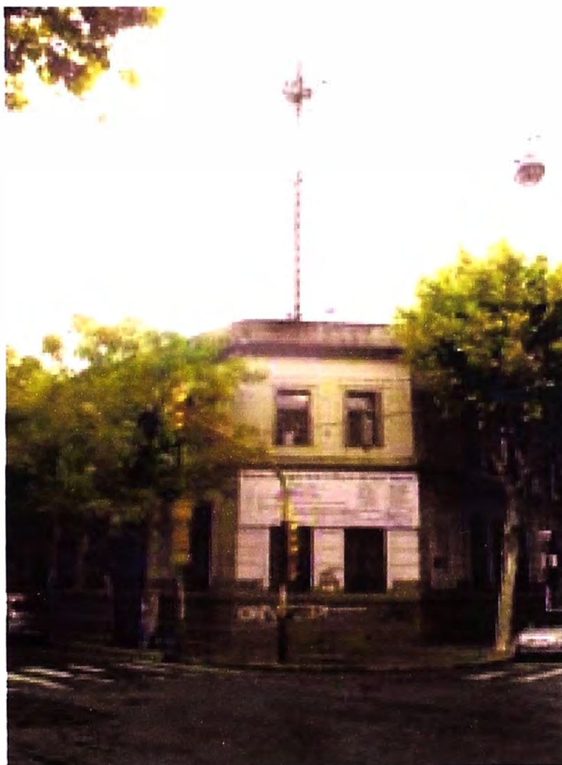
FIGURA 3.9 Estación Base Celular Urbana
