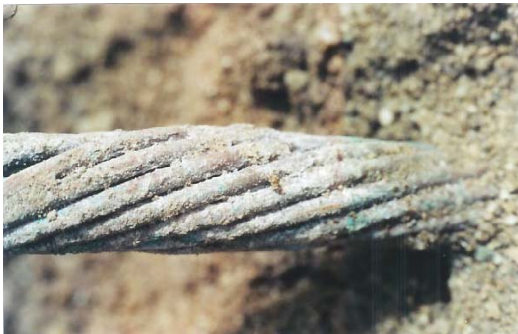
Foto 01. Superficie del conductor enterrado de la Red de Puesta a Tierra existente; se observa sólo una delgada capa de Sulfato de Cobre producto de la corrosión bacteriana, no obstante se mantiene en buen estado.
