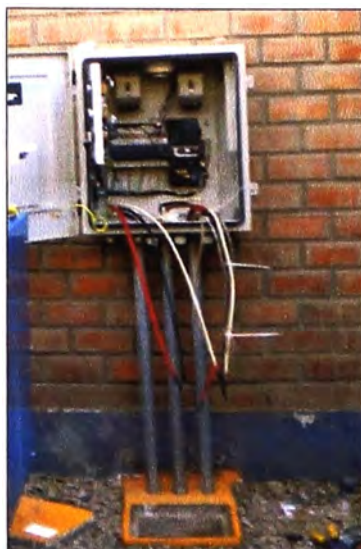
Figura 4.14 Conexión de conductores NYY
