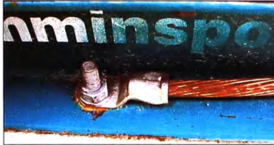
Figura 4.9 Detalle de aterramiento
