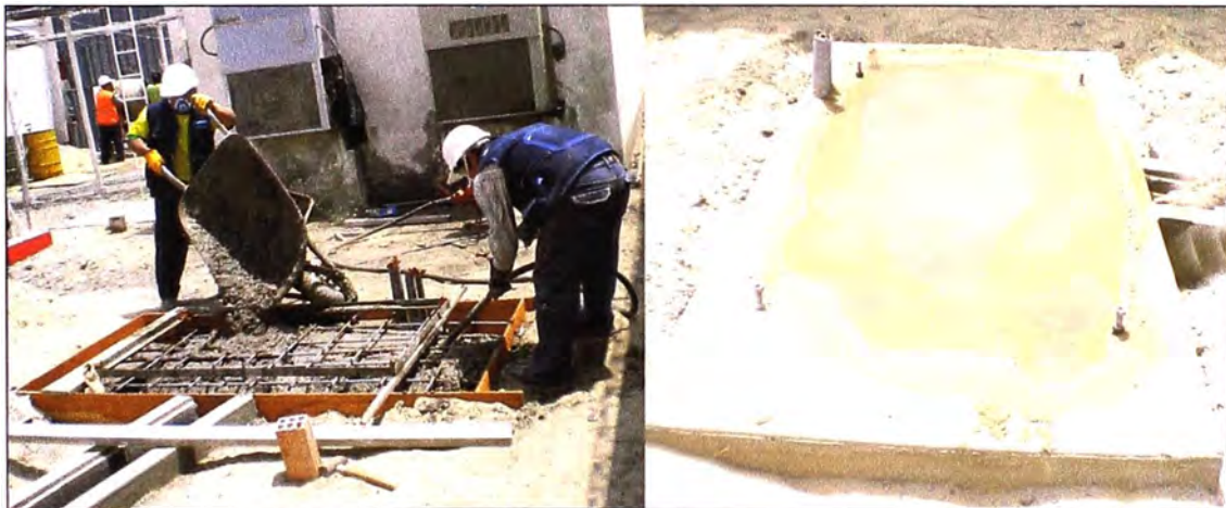
Figura 4.5 Plataforma de concreto
