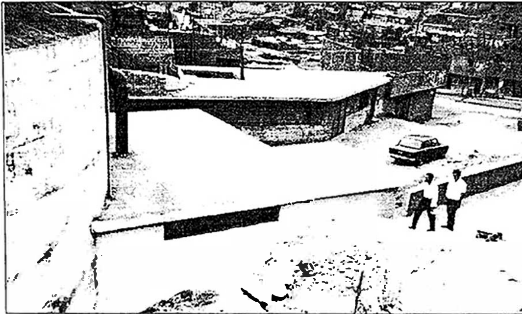
Caseta del Reservorio R1 donde se construirá un segundo piso para el equipamiento nuevo
