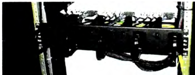
Fig. 3.4.2 Fotografía del cableado eléctrico de una estación base.
