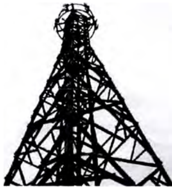
Fig. 3.4.5 Torre para soporte de antenas
