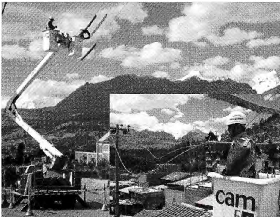
Fig.5.1 Conexión de nuevas redes utilizando el brazo hidráulico
