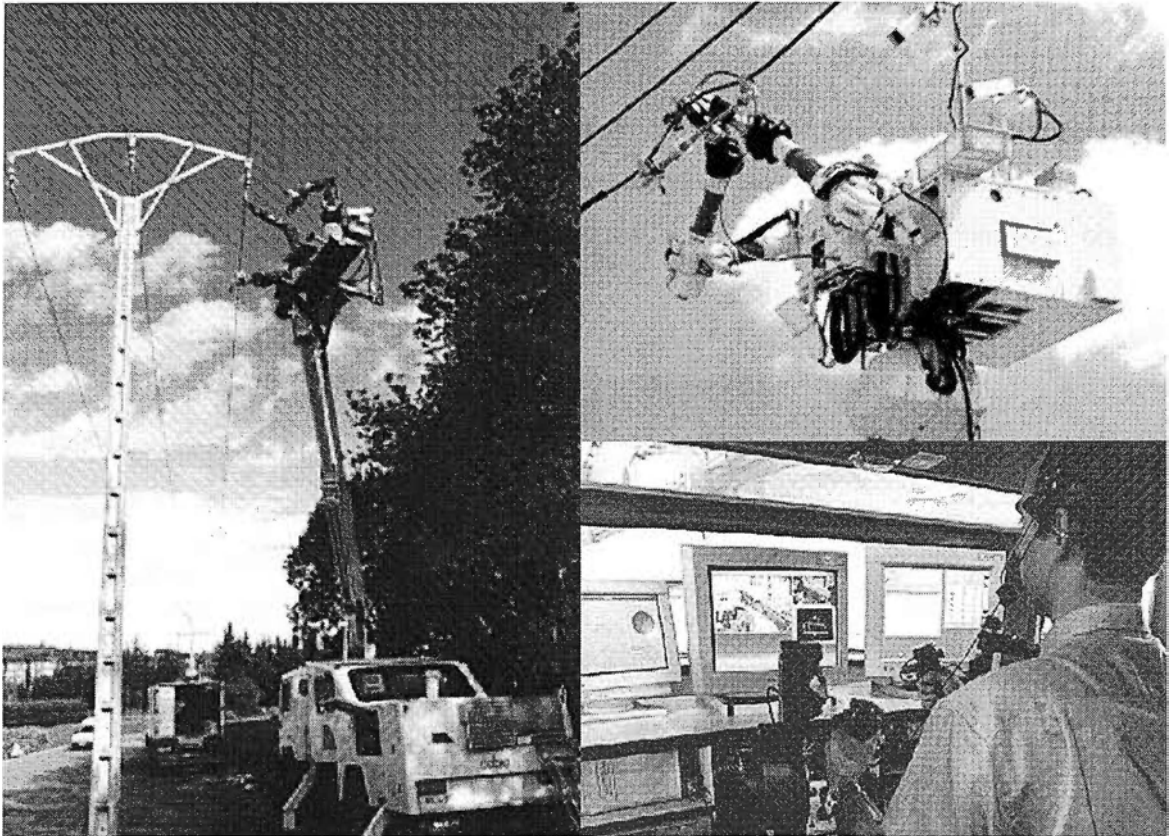
Fig. 2.7 Aplicaciones de los Trabajos Robotizados.
