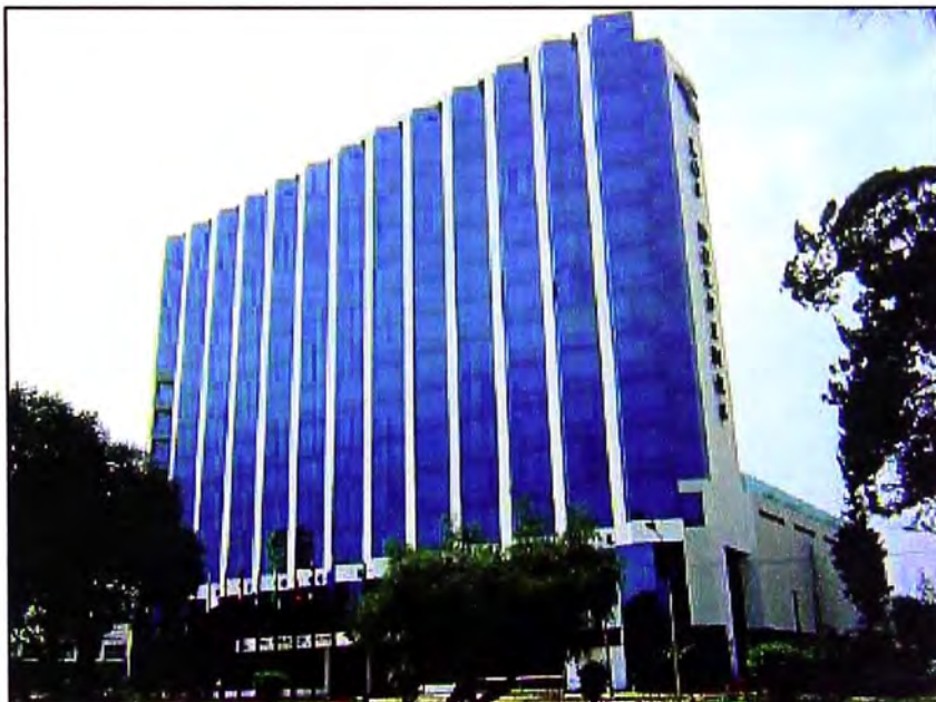
Fig.2.10 EBC Los Delfines, ubicado en las instalaciones del Hotel "Los Delfines".
