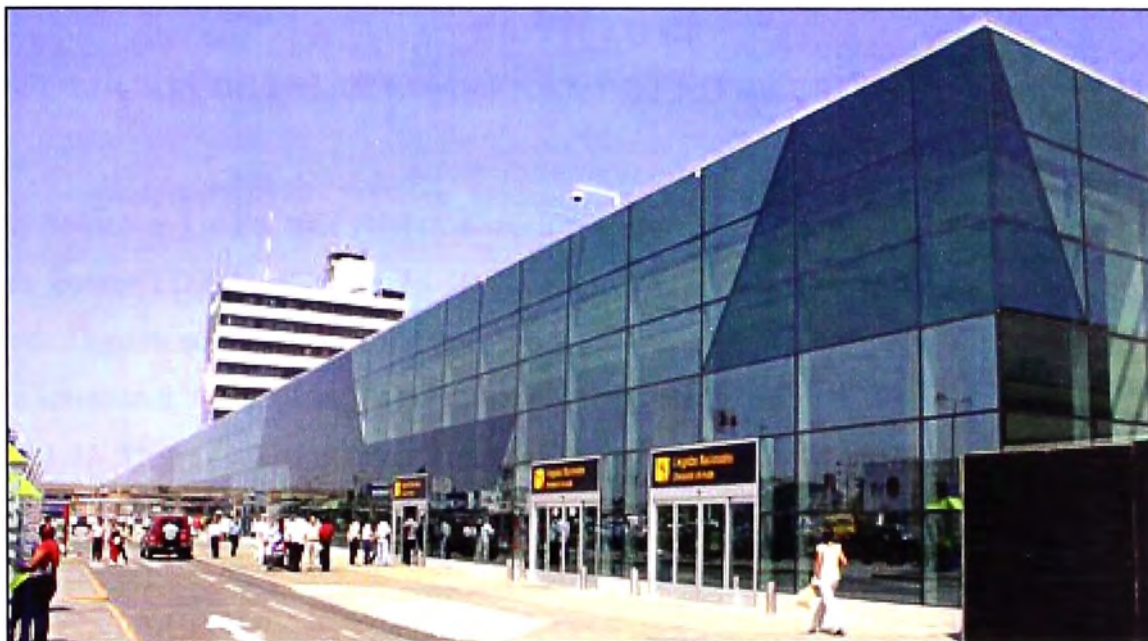
Fig.2.16 EBC Aerolap, instalado dentro del Aeropuerto Jorge Chávez.
