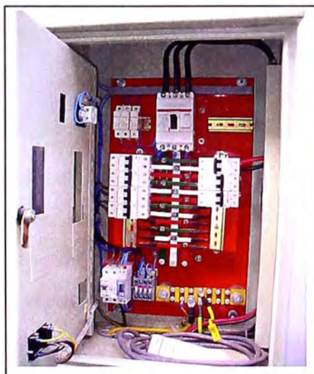
Fig.1.7 Tablero de energía AC y barra de tierra.
