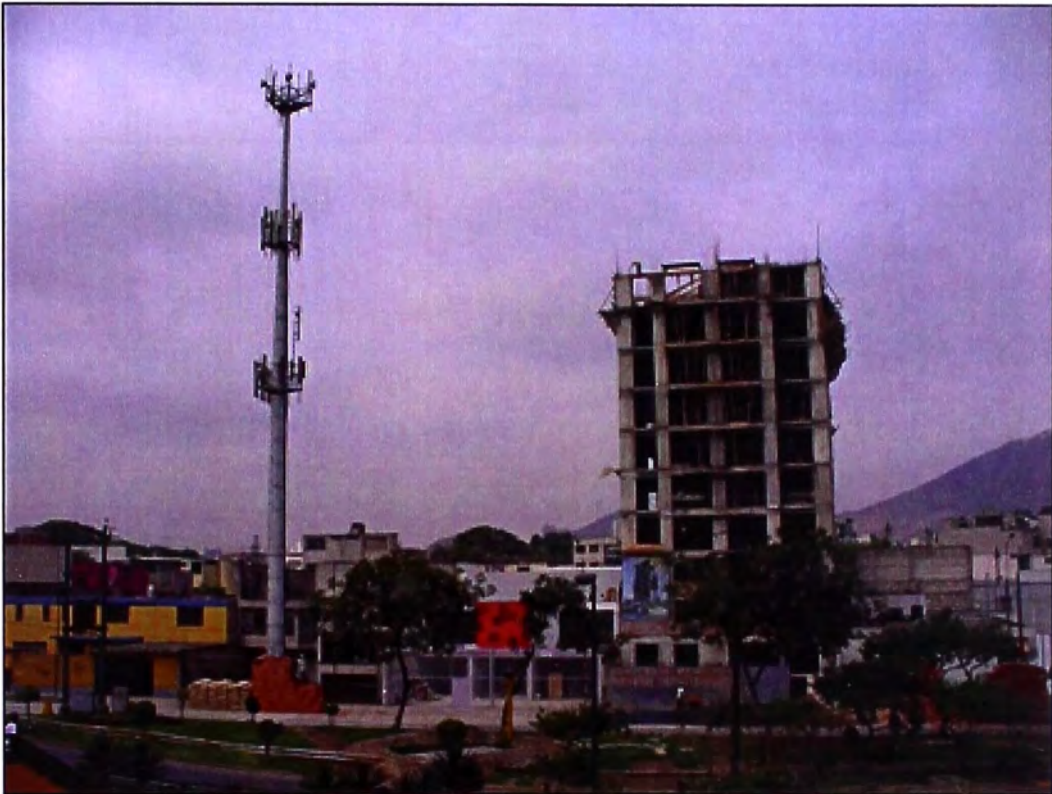
Fig.2.13 EBC Primavera, con un edificio que obstruye la señal de las antenas instaladas.
