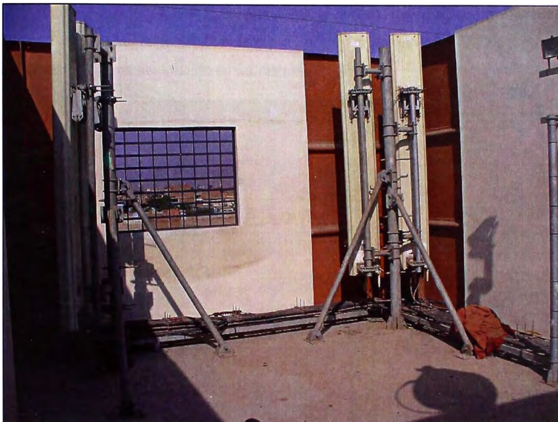
Fig.3.21 La misma EBC visto por dentro, donde se muestra las antenas GSM dual band instalados.
