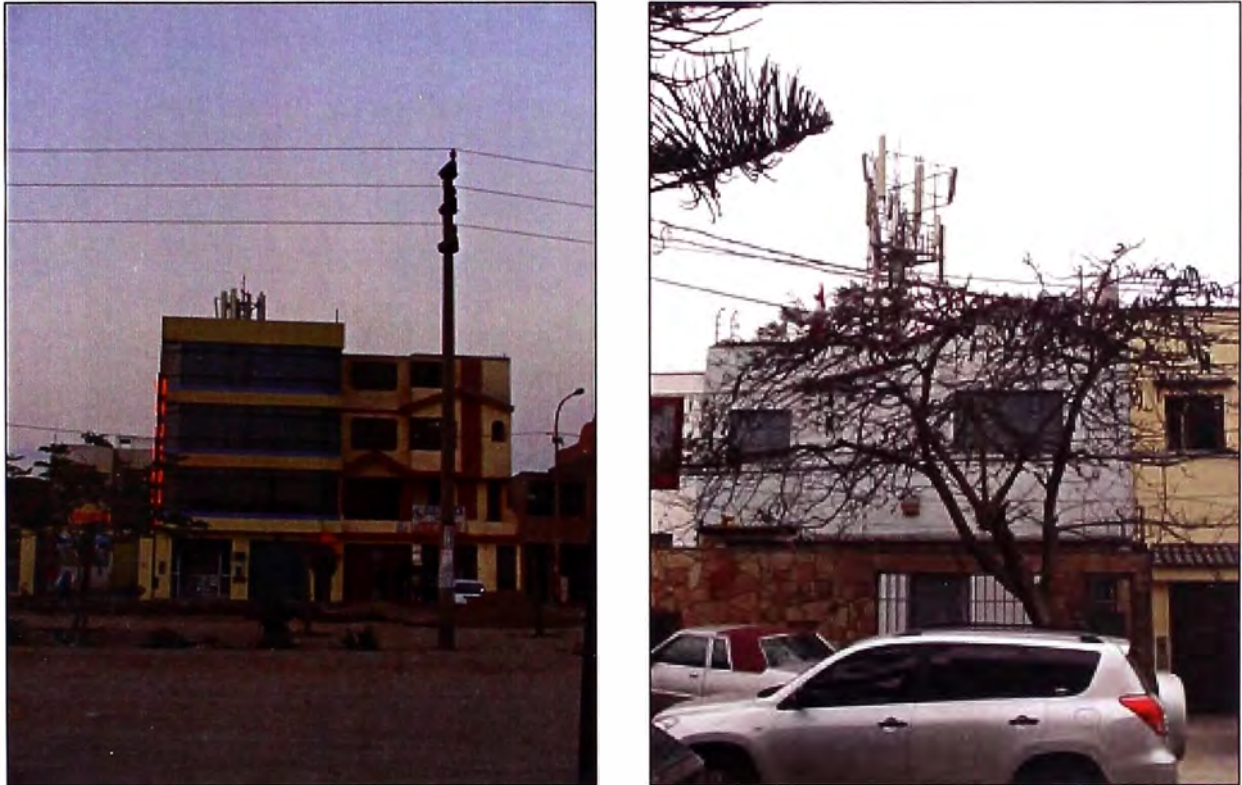
Fig.2.6 EBCs con antenas instaladas a una altura menor a la deseada.
