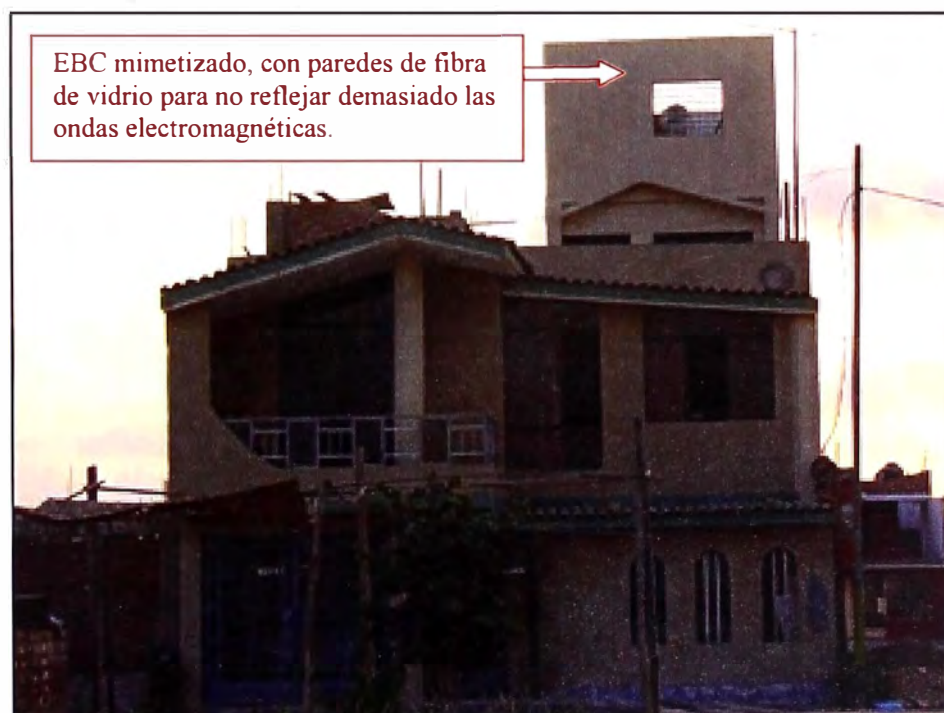
Fig.3.20 EBC visto por fuera, con apariencia de una casa familiar de la zona.
