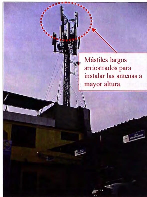
Fig.3.23 Ampliación de torres con mástiles.
