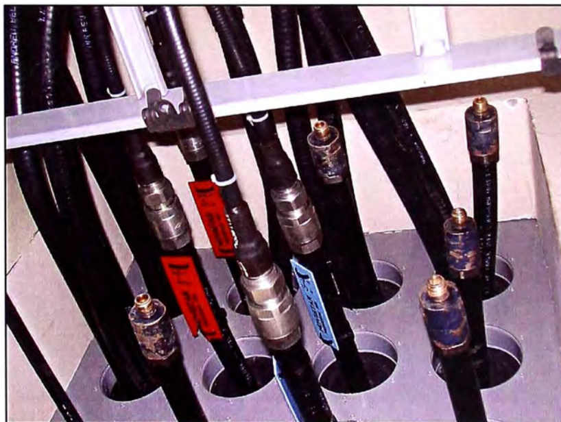
Fig.2.12 Cables feeder libres que el Operador pide reutilizar para la red GSM.
